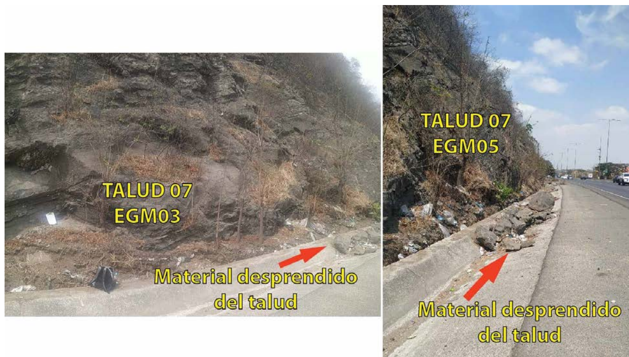
Figura 5. Desprendimiento de material rocoso en Talud 07 (EGM03-05) (Elaboración propia).
