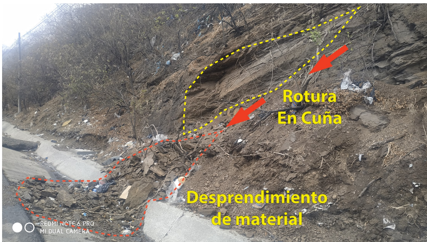
Figura 4. Rotura en cuña y material desprendido de Talud #10 (EGM02) (Elaboración propia).
